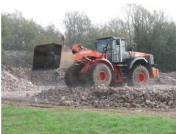
Début aout, c'est le démarrage du gros chantier de la construction de la bergerie. Le terrassement et le chemin d'accès ont été rapidement exécutés par de gros engins qui ont remodelé le paysage. Les fondations ont été coulées et le maçon a préparé les piliers pour la pose de la charpente prévue début novembre.
